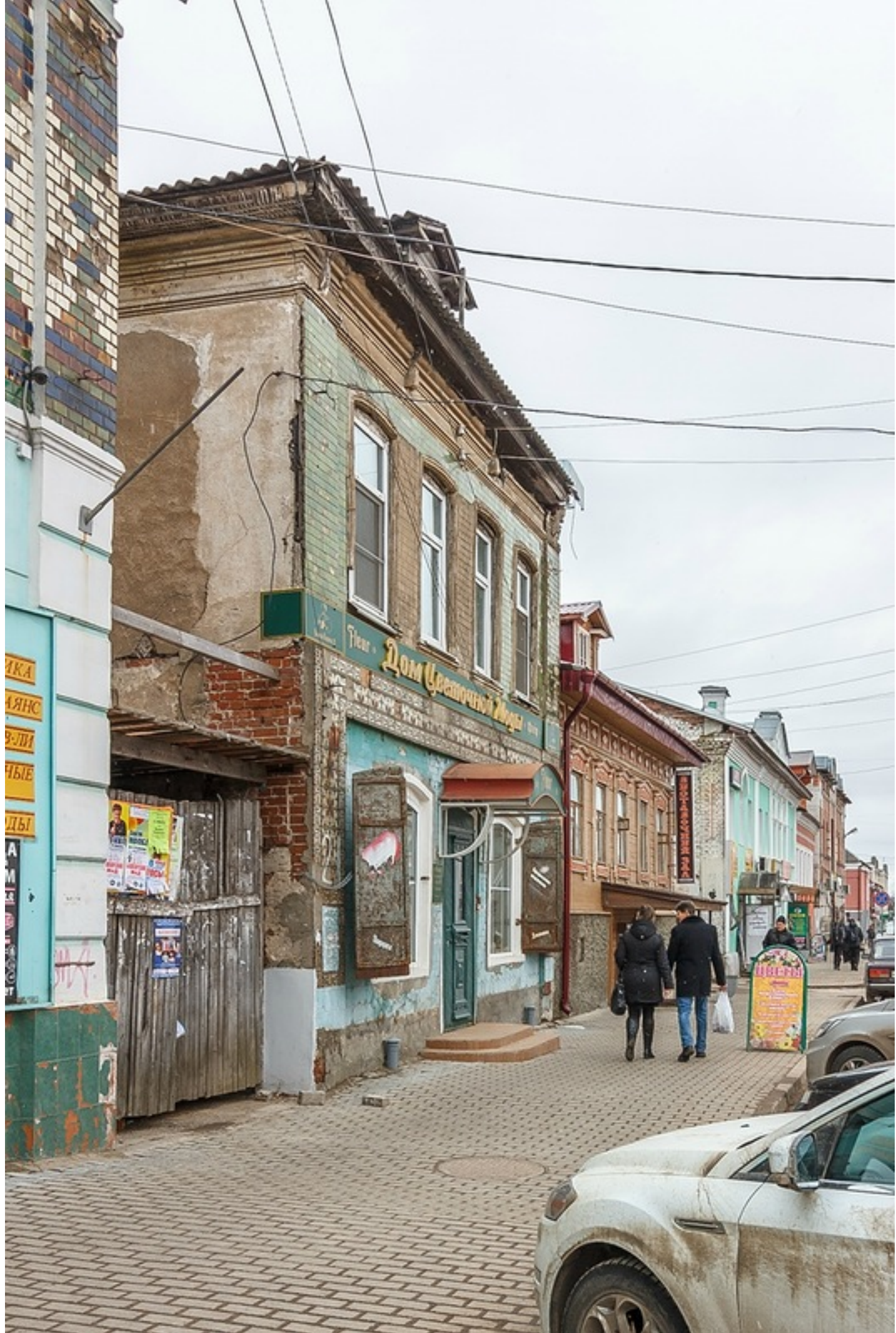
Дома по ул.Кирова
