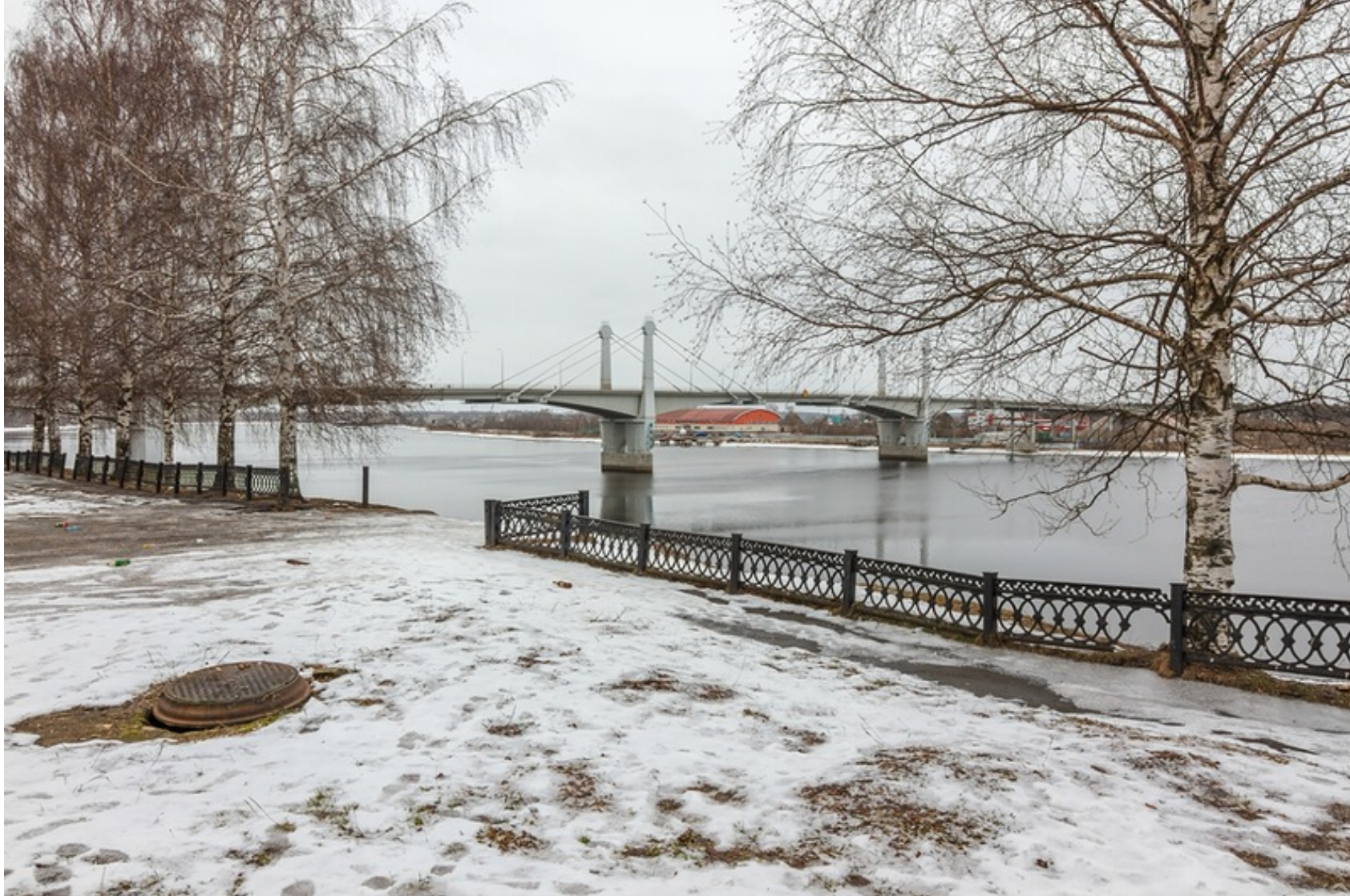
Кимрский автомобильный мост через р.Волгу
