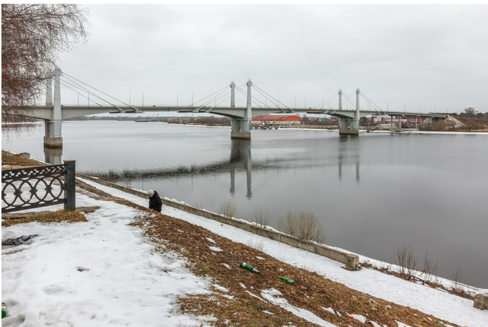
Кимрский автомобильный мост через р.Волгу
