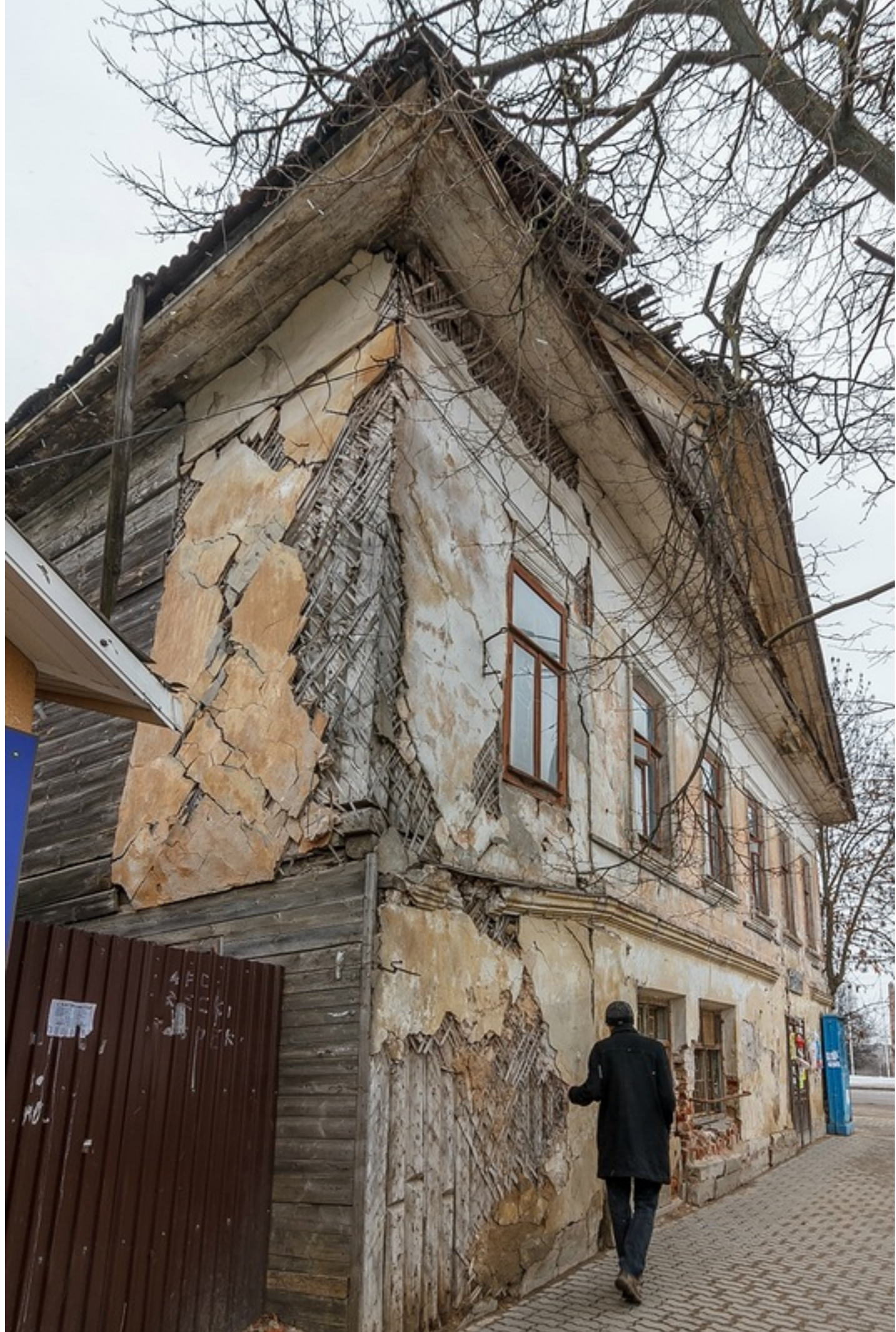
Заброшенный дом на углу улиц Володарского и Урицкого
